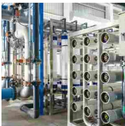
Impianto per la desalinizzazione delle acque di Italmatch Chemicals
